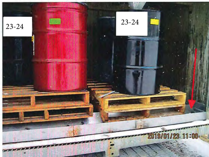
IMG_1448.JPG Image 2. vue intérieur de l'abri avec bassin de rétention (flèche)
